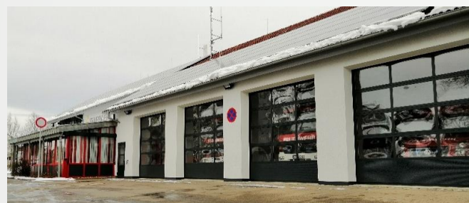
Vorbereitungen für den Neubau
